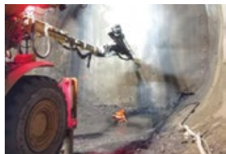
Creusement du tunnel en Maurienne (Chantier opérationnel 08 à Saint-Julien-Montdenis, 2024) - Photo : J. Colonna
