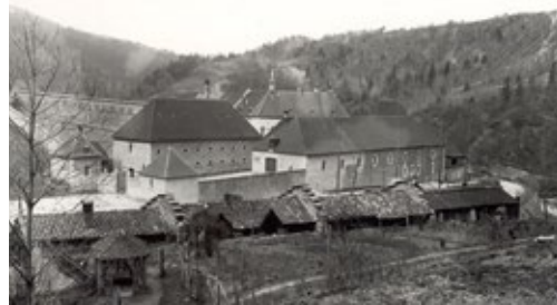
Ancienne distillerie des Chartreux à Fourvoirie (St-Laurent-du-Pont) Photo : Coll. Musée Dauphinois
