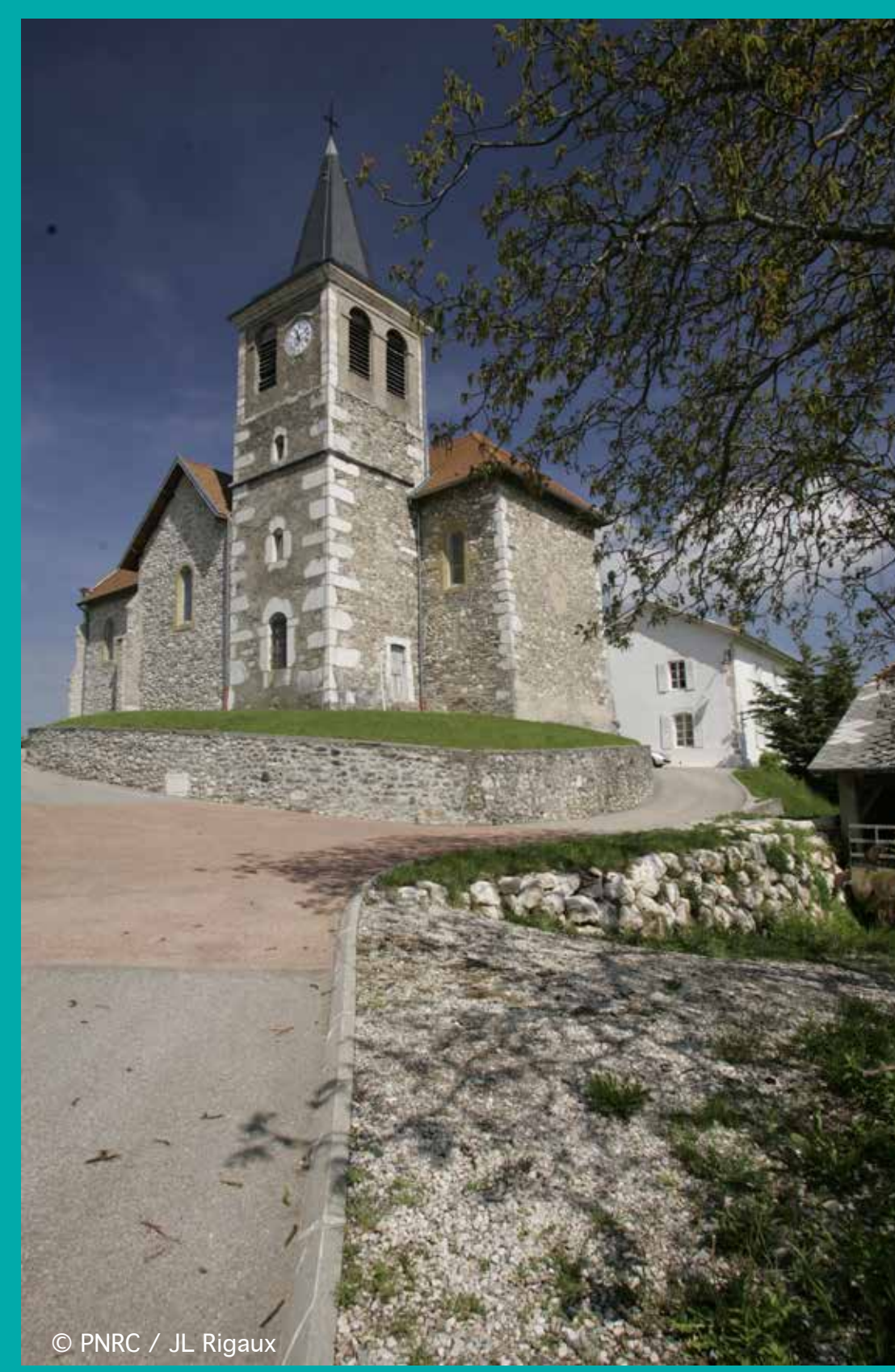
© PNRC / J.L. Rigaux Eglise de Voissant
