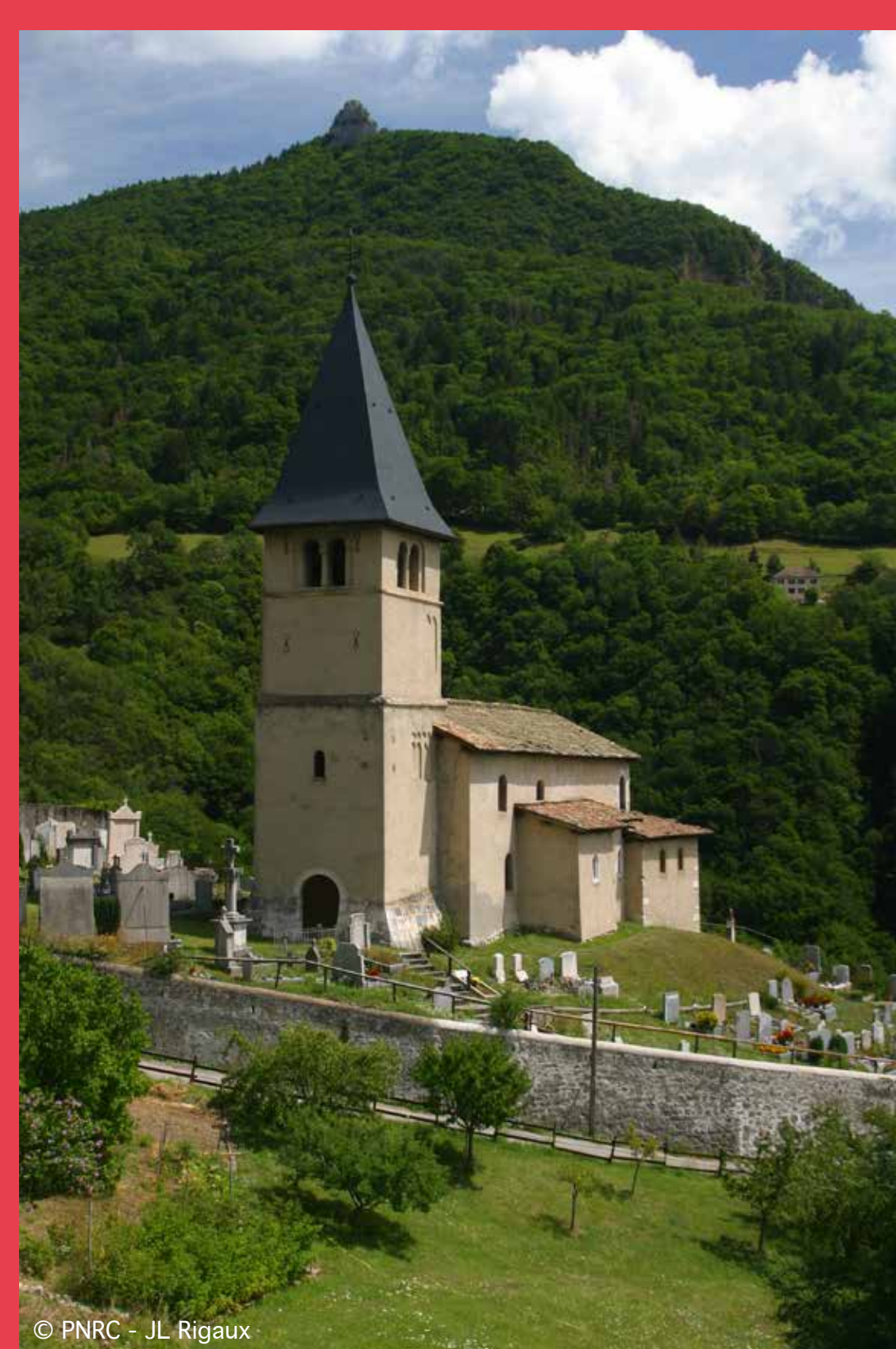
© PNR - JL Ripan Église de Proveysieux
