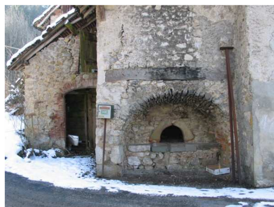
Four à pain intégré au corps de bâtiment – Jaloutière
