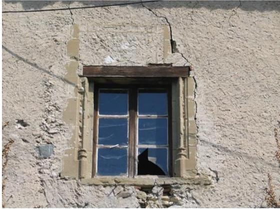
Fenêtre à traverse élargie à baguettes et base prismatique – la Roche
