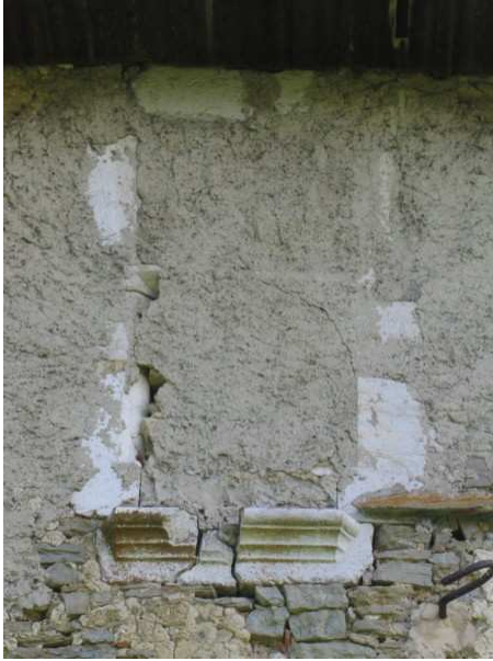
Fenêtre à traverse murée – la Combe- Dessus
