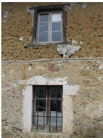
Élévation en moellons et pisé
