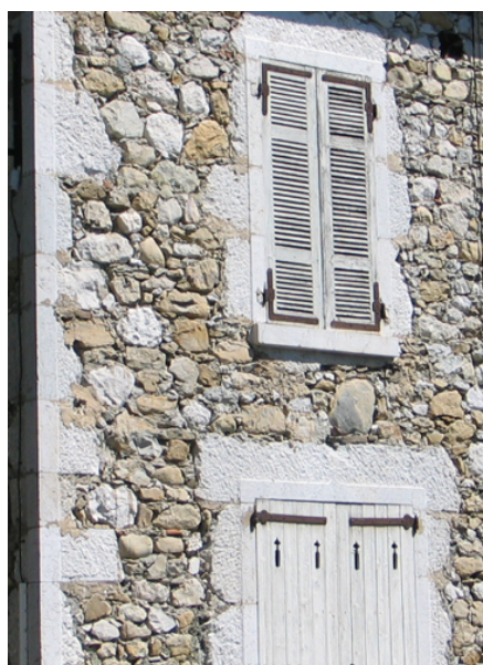
Détail de maçonneries en attente d'un enduit – Champcornu
