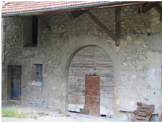
Percements en mur-gouttereau – Montaliieu
