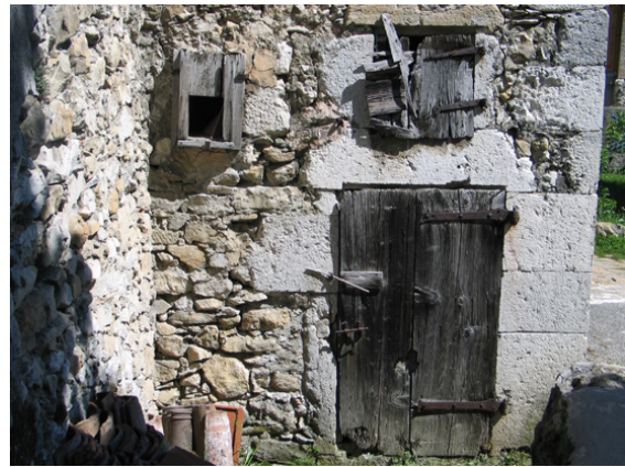
Loge à cochon et poulailler intégrés à une maison vigneronne – Saint-Vincent
