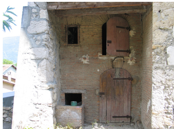
Loge à cochon et poulailler installés dans un hangar de grange-étable, présentant une belle façade de brique – Champcornu
