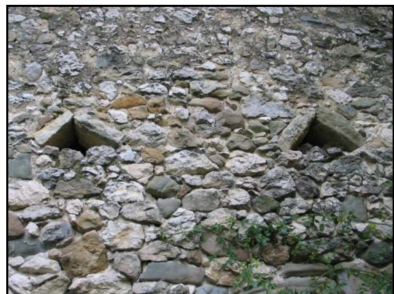
Percements d'aération dans pignon de grange
