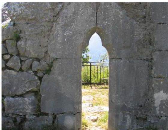
Baie d'origine médiévale – Château du Gouvernement
