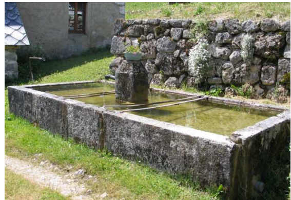
Fontaines en dalles de calcaire agrafées – le Grand Chenevey et les Reys
