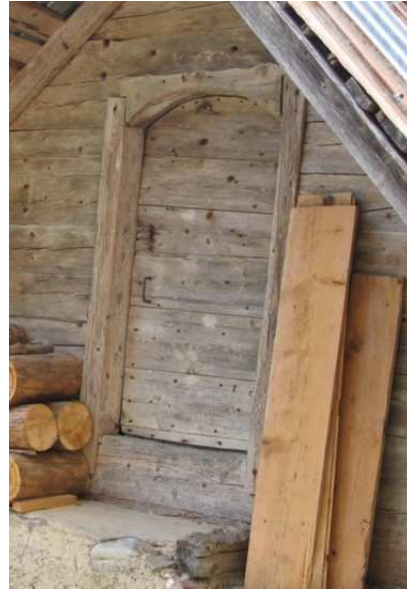
Porte couverte d'un arc segmentaire ouvrant sur la chambre – grenier à Saint-Philibert
