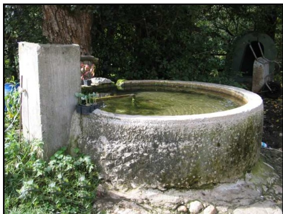
Fontaine à bassin circulaire en pierre de taille
