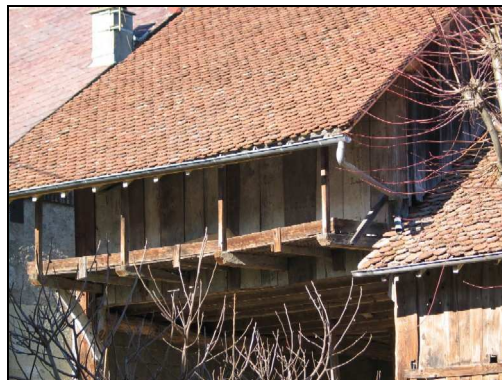
Séchoir à noix en sacoché sous dépassée de toiture.
