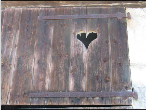
Percement d'aération dans une porte de grange.
