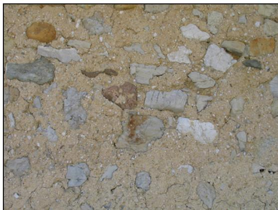
*Maçonnerie de moellons calcaires enduits à pierres-vues au mortier de chaux*
