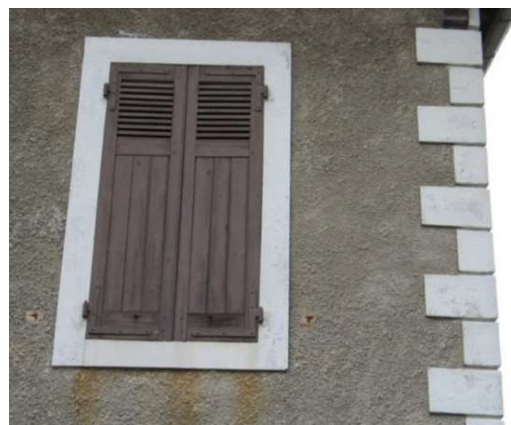
Chaîne d'angle harpée en ciment moulé
