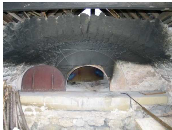
Four à pain doté d'une avant-voûte
