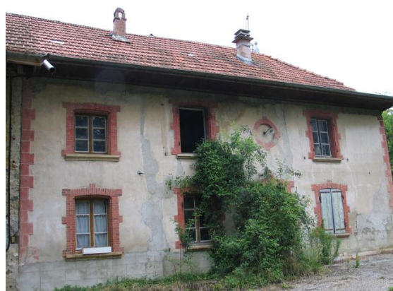
Encadrements segmentaires en briques – Au Pecoud
