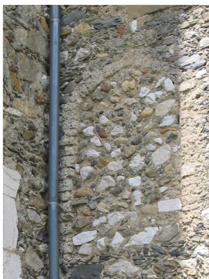
Ancienne baie en tuf – Mur sud du chevet
