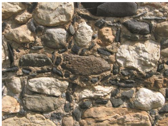
Détail de maçonneries en pierre – la Garonnière
