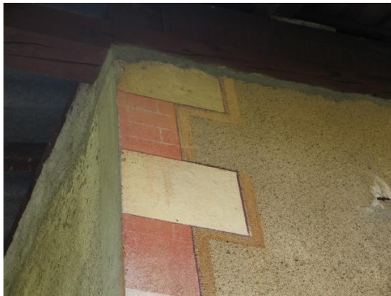
Décor de harpage en chaîne d'angle – le Bourg
