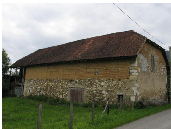
Élévation en pisé d'une grange-étable – Chambuaire
