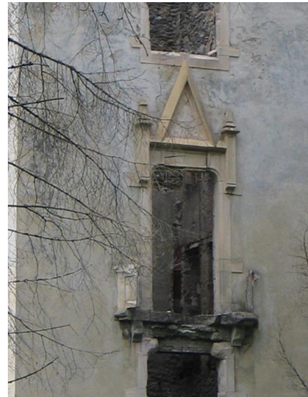
Baie de style néo-gothique – Château Descours
