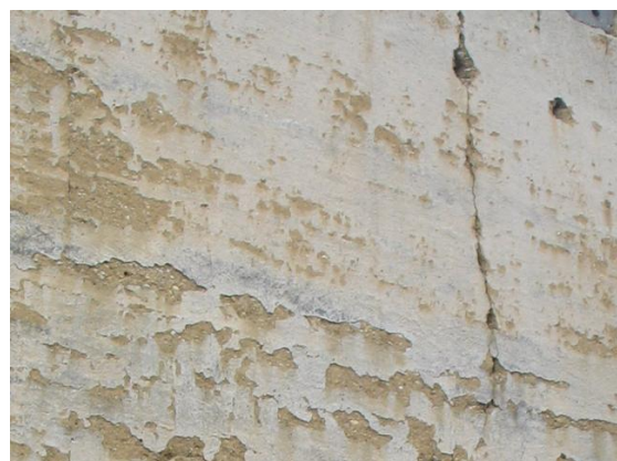
Pisé recouvert d'un badigeon à la chaux – Aux Champagnes
