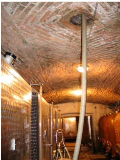
Décor d'une voûte appareillée en briques
