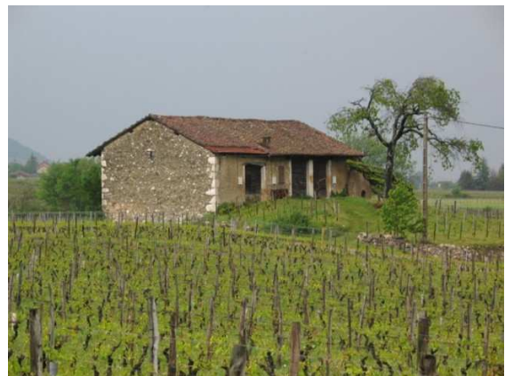
Celliers dans les vignes
