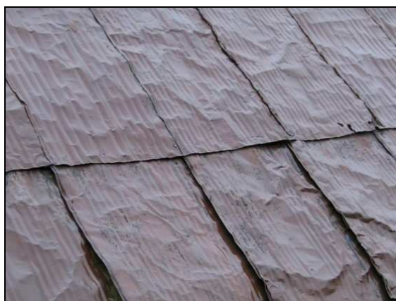
Couverture de toit en tôle de bidon déroulée
