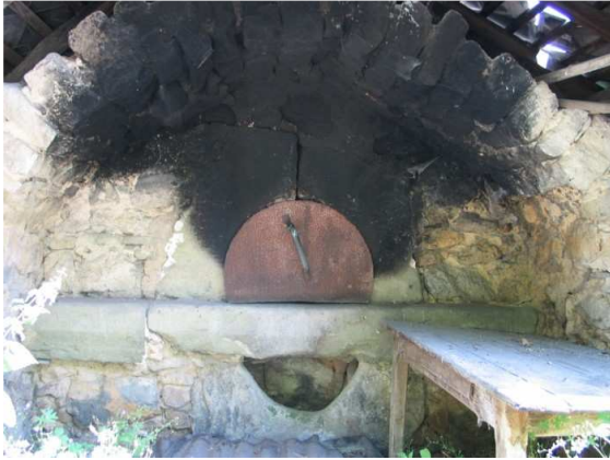
Structure du four à pain de la Vielle Fourche : cendrier, avant-voûte...
