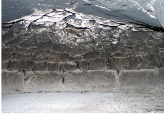
Voûte d'un four à pain montée en moellons de molasse
