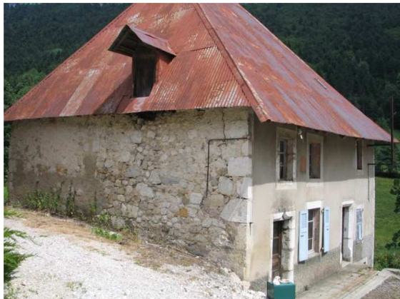
Couverture en tôle ondulée d'un toit à quatre pans doté d'une lucarne – les Cruz
