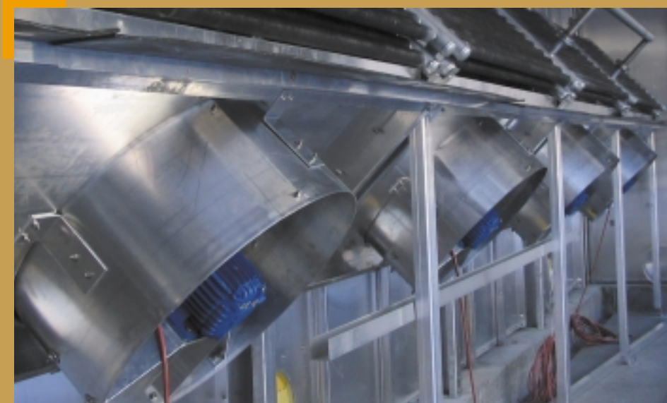
Intérieur d'une cellule du séchoir.
