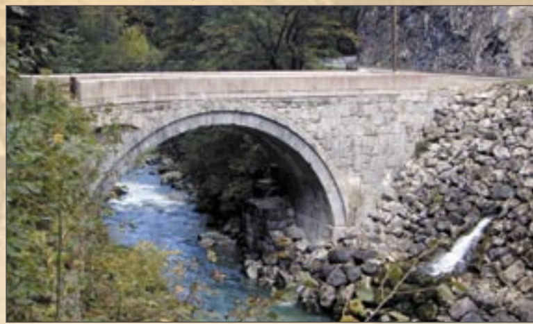
Pont du Grand Logis
